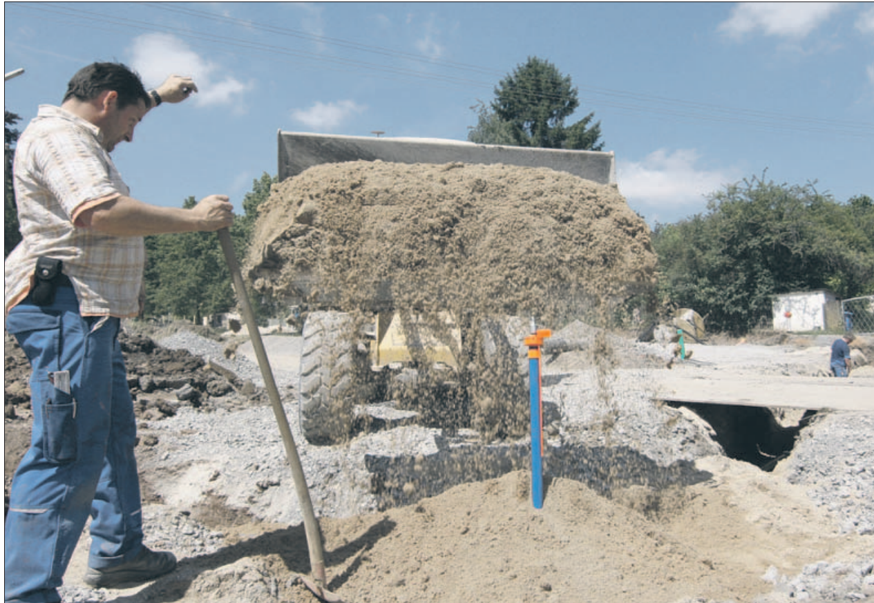
Die Wasserleitungsrohre sind verlegt: Jürgen Ströbel deckt den Graben mit Sand zu.
