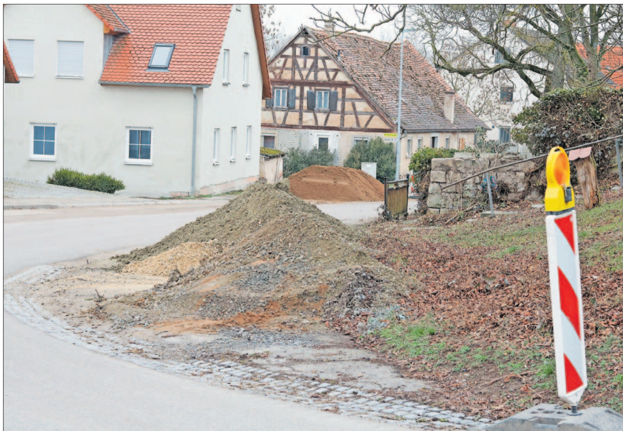
Voraussichtlich Anfang April starten die Straßenbauarbeiten in Schwebheim, die noch unter der Voraussetzung von Straßenausbau-Beiträgen geplant worden waren. Foto: Günter Blank
