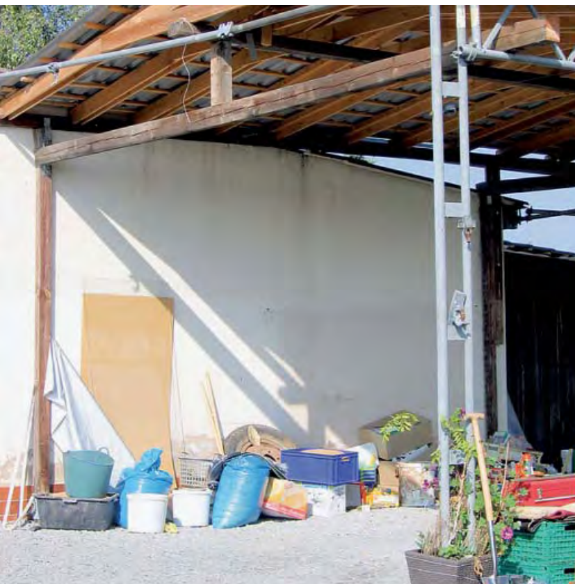
Für Blumenfreunde mögen die in bepflanzten Kübeln verschwindenden Träger des Unterstands vielleicht schön anzusehen sein. Nach der Einschätzung von Statikern können sie allerdings eine echte Gefahr darstellen. Foto: Berger
