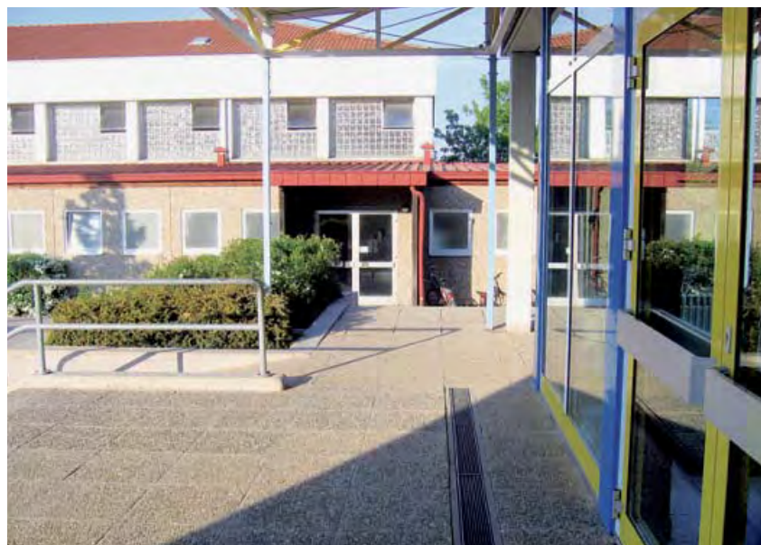
Bei der Standortfrage eines Neubaus spielt auch die räumliche Nähe von Schulhaus und Turnhalle eine Rolle. Foto: Berger
