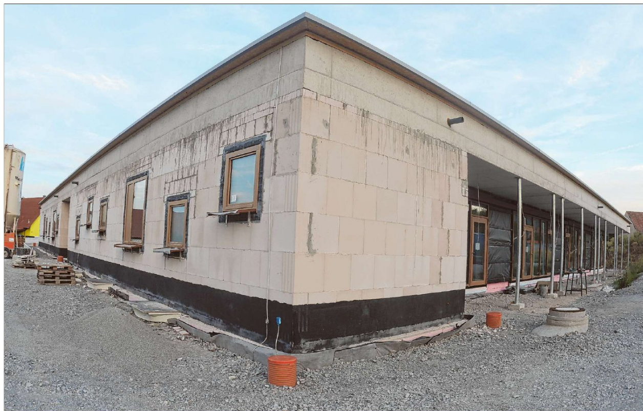
Der neue Kindergarten am Gartenfeldweg wird noch länger Baustelle bleiben als geplant.
