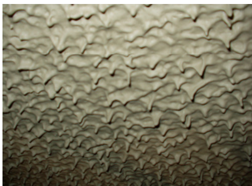
Tropfputzstruktur zur Vergrößerung der Oberfläche
