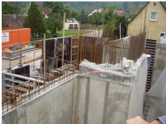
Rohbau HB-TZ Herzfleckenweg
