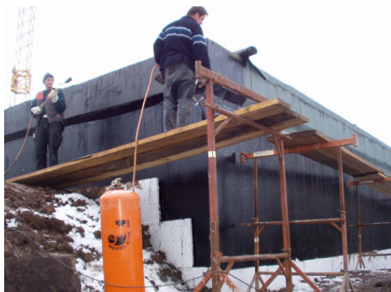
Abdichtungsarbeiten an der Behälterdecke
