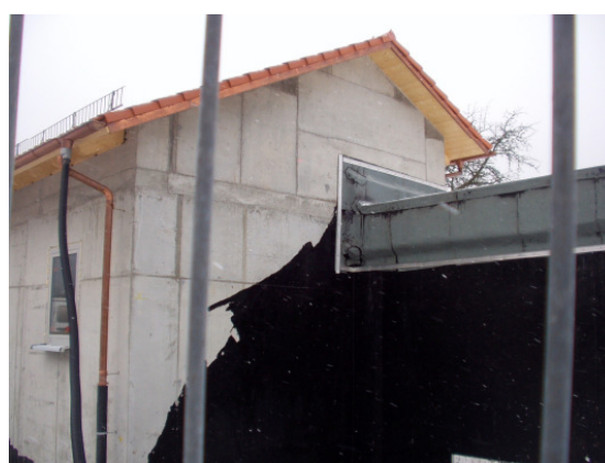
Anschluss der Behälterabdichtung an den Rohrkeller
