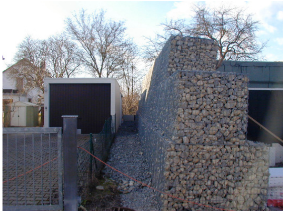
Gabionenwand als Abrenzung
