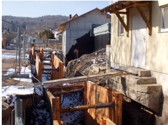
Verbindung der Leitung vor den Behältern
