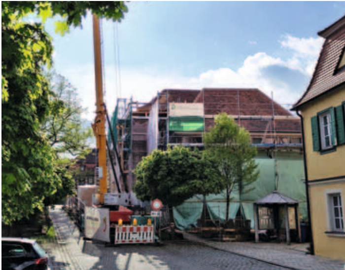
Die Dächer werden mit gebrauchten Biberschwanzziegeln eingedeckt (Foto: Nadine Höhne)
