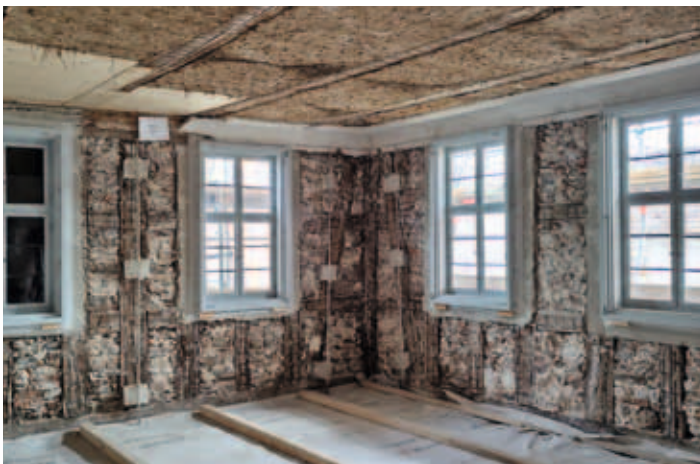
Die restaurierten Fenster wurden im Gebäude Marktplatz 6 eingebaut (Foto: Nadine Höhne)
